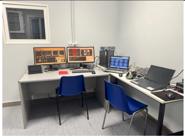
Figure 5 – Sala di controllo
